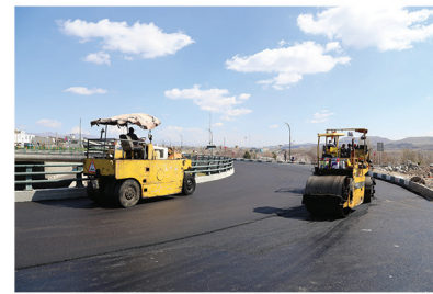
آسفالت ریزی و لکه گیری
